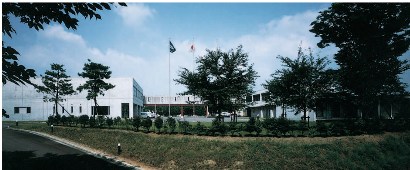
白河工場全景
