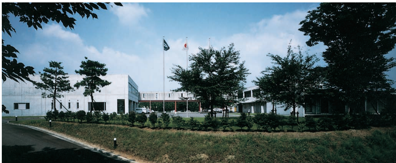
白河工場全景
